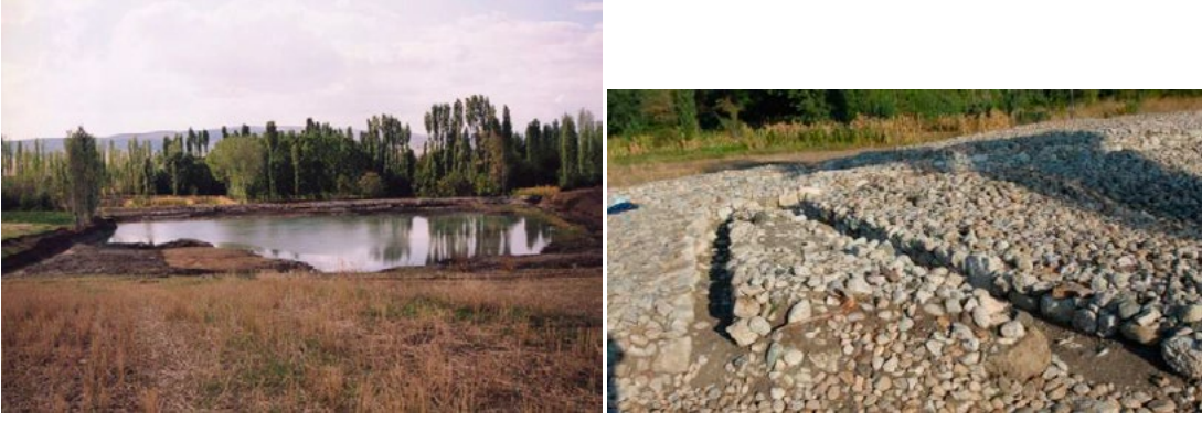
Şekil 1 Baraj Genel Görünümü(DSİ, 2009).Şekil 2 Savak Görünümü(DSİ, 2009).
