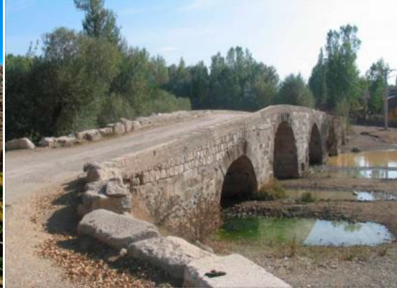
Şekil 11 Çekerek Irmağı-Sulusaray Köprüsü (Fotoğraf Ülke ve Kebapcıoğlu, 2015).
