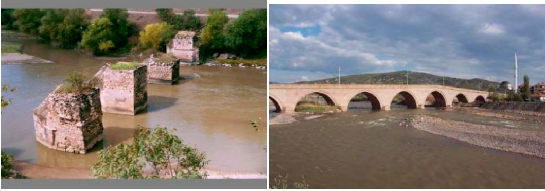
Şekil 12 Kaleköy Köprüsü.(İnternet 3). Şekil 13 Bayazıt II Köprüsü.(İnternet 4).
