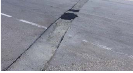
Şekil 2 Rijit malzeme ile üstyapı tamiri örnekleri.
