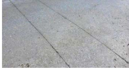
Şekil 7 Yol yüzeyinde oluşturulan kesiklerin örnekleri.
