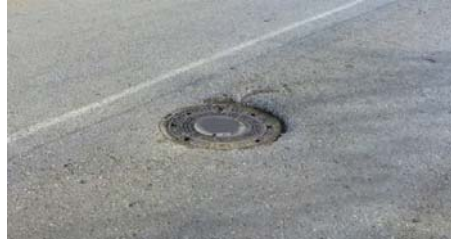
Şekil 3 Rögar kapaklarının yol kotuna göre düşük kotta yapılan imalat örnekleri.
