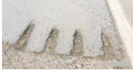
Şekil 6 İş makinelerince oluşturulan hasar örnekleri.
