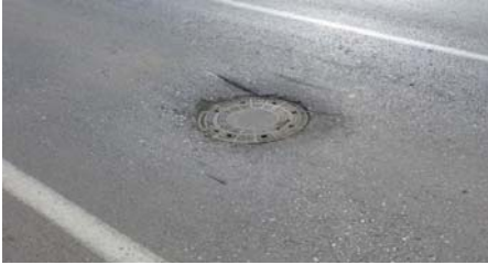
Şekil 3 Rögar kapaklarının yol kotuna göre düşük kotta yapılan imalat örnekleri.
