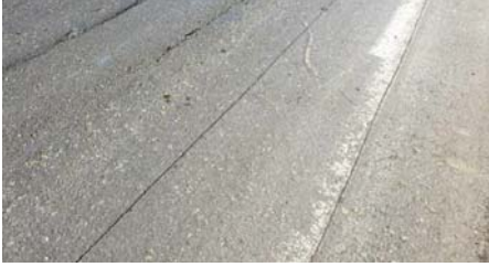
Şekil 7 Yol yüzeyinde oluşturulan kesiklerin örnekleri.
