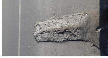
Şekil 2 Rijit malzeme ile üstyapı tamiri örnekleri.
