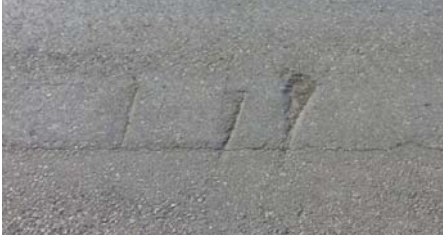
Şekil 6 İş makinelerince oluşturulan hasar örnekleri.
