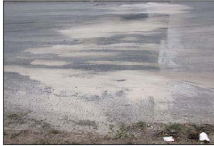
Şekil 5 Kavşak noktalarında görülen kuma bozulmasını iyileştirmek için kum malzemesinin uygulanması (TxDOT,2004).
