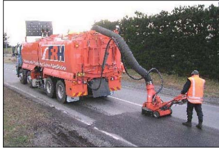
Şekil 8 Ultra yüksek basınçlı su kesici makinesi (AAPA, 2004).
