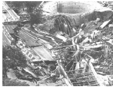
Resim-2 Singapur metro inşaatı
